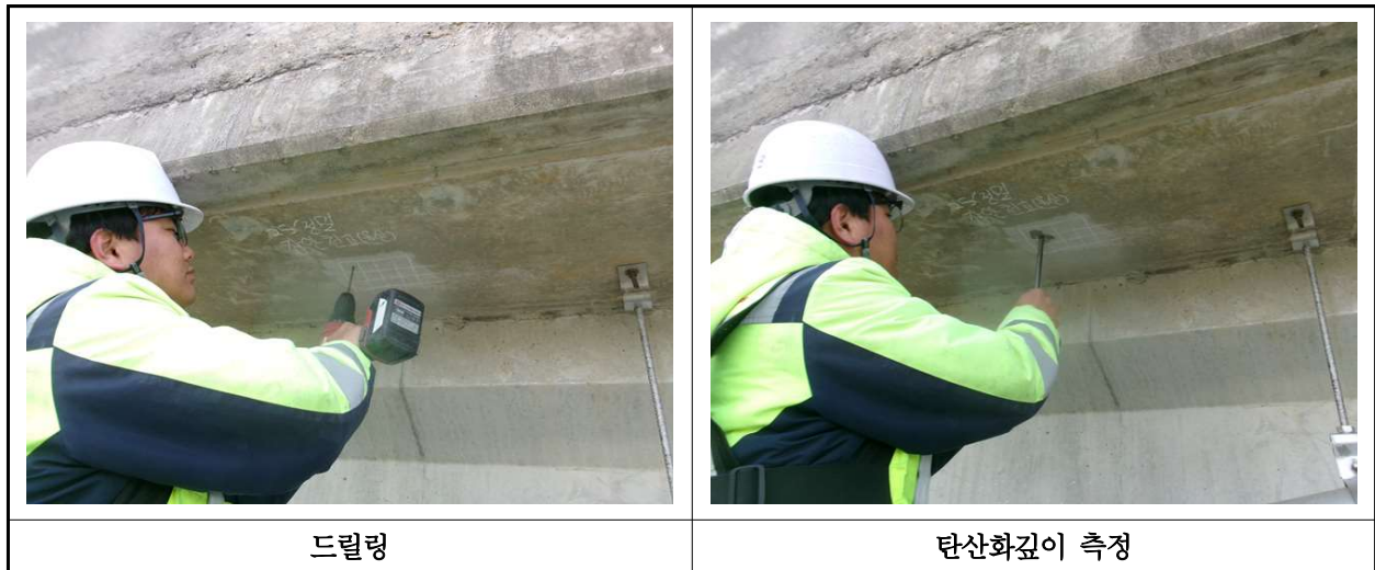
【사진 41.4.3】 탄산화 깊이 측정 현장사진
