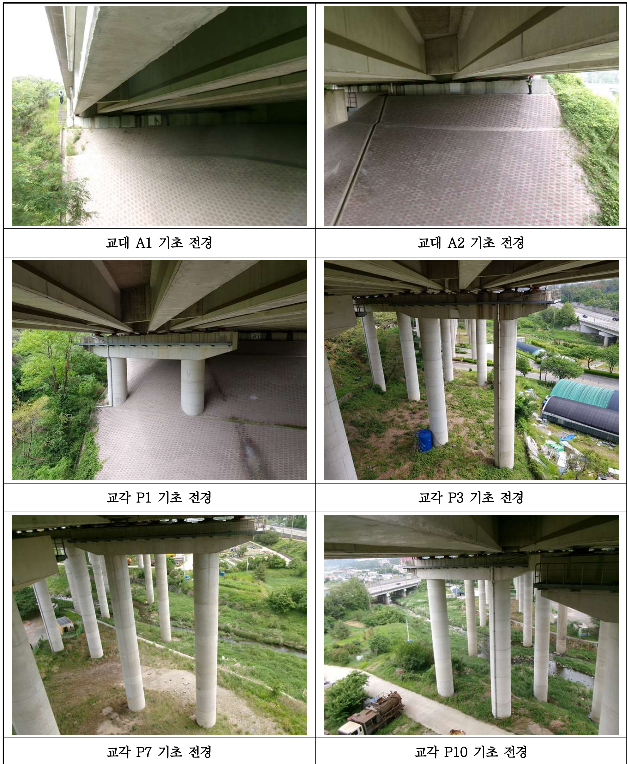
【사진 41.3.12】 기초 전경
