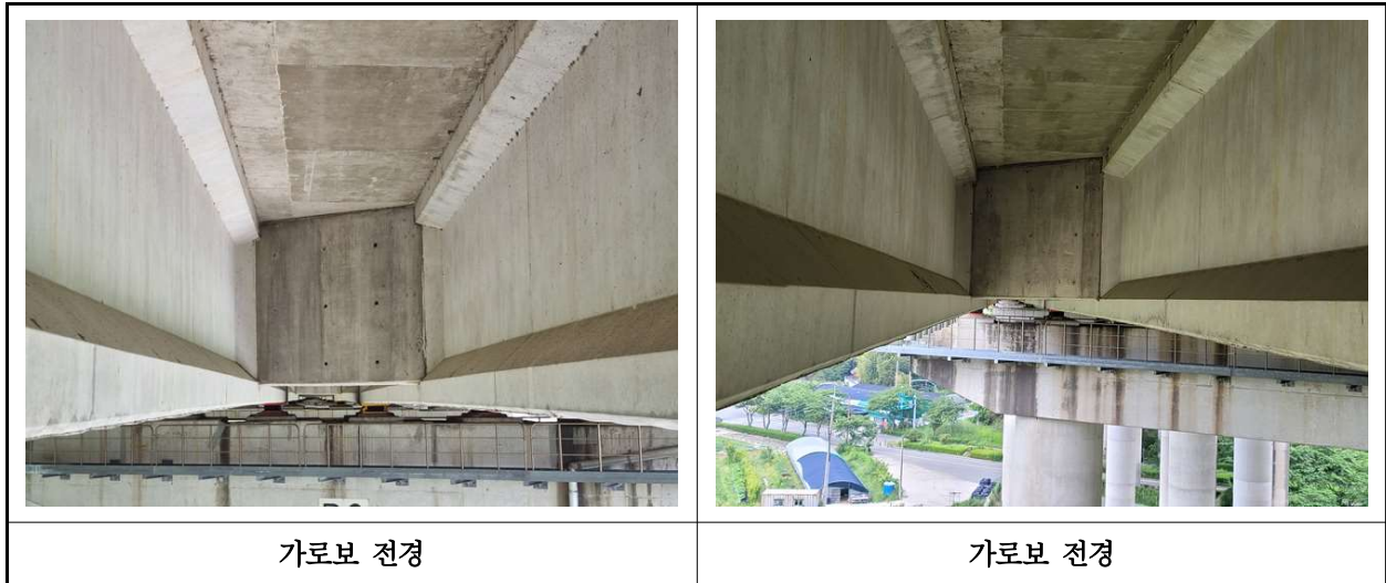
【사진 41.3.6】 가로보 전경
