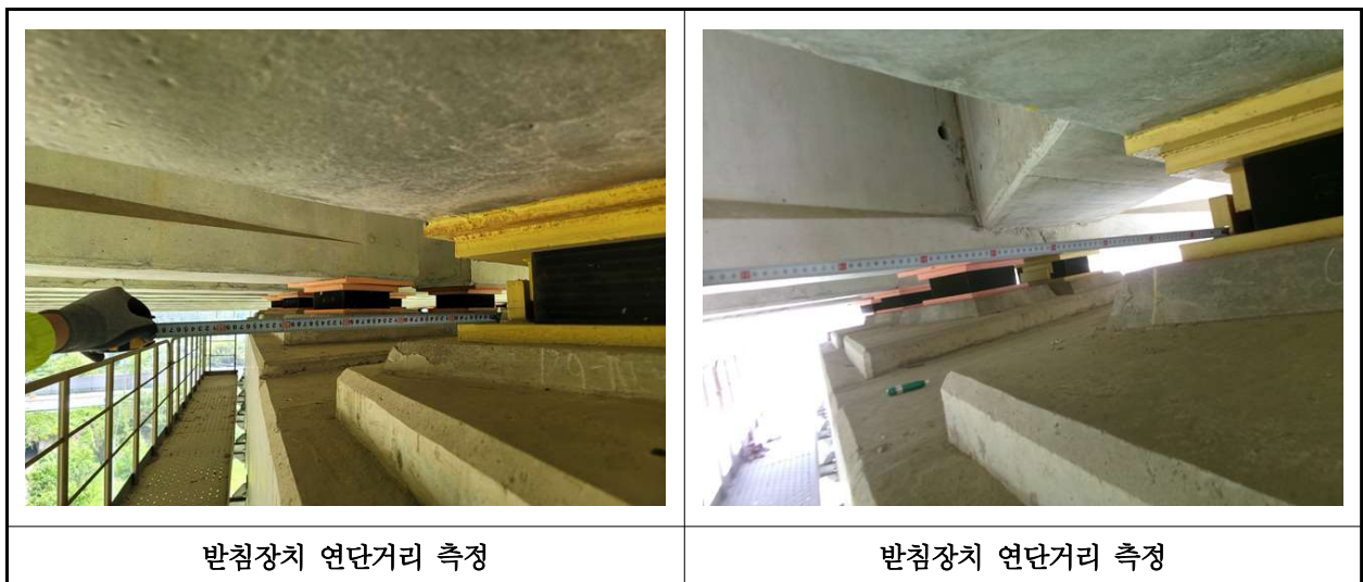
【사진 41.3.15】 교량받침장치 연단거리측정
