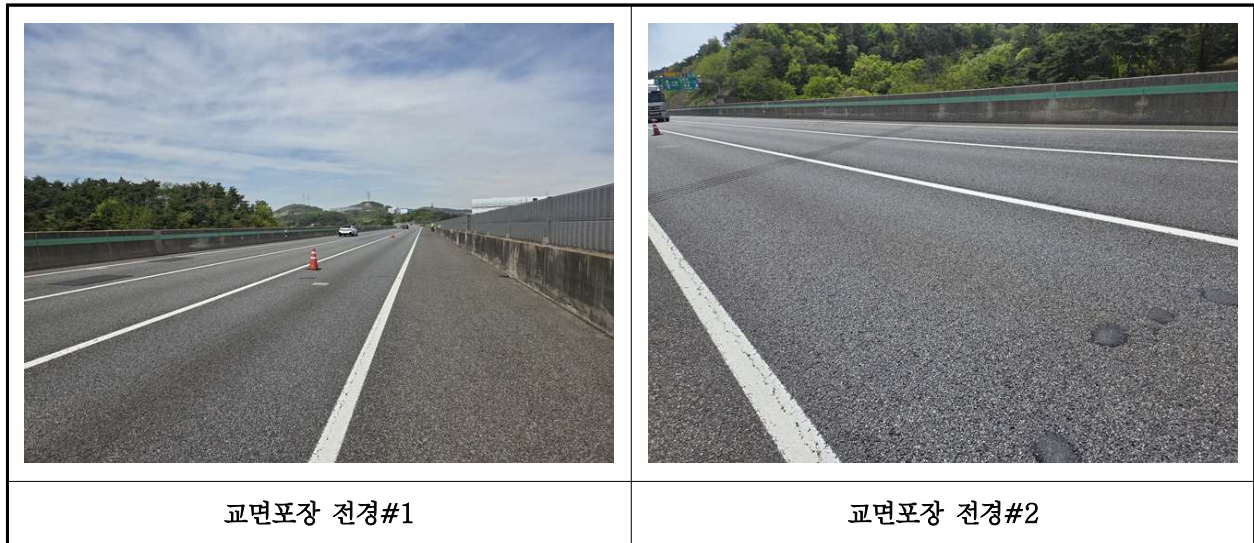
【사진 41.3.20】 교면포장 전경
