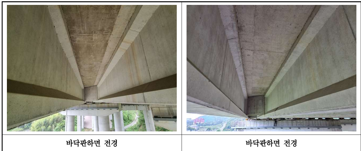
【사진 41.3.2】 바닥판하면 전경
