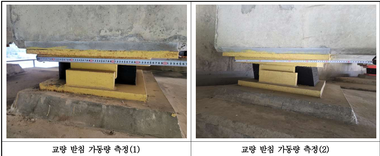
【사진 41.3.16】 교량받침 이동량 측정
