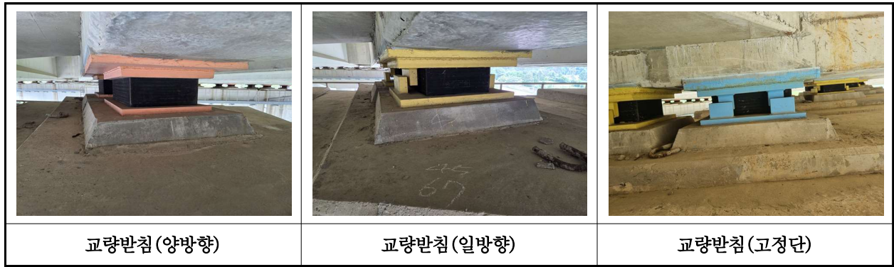
【사진 41.3.13】 교량받침 전경
