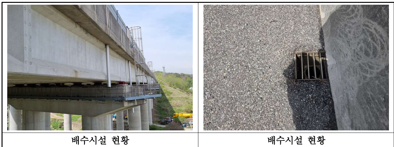
【사진 41.3.22】 배수시설 전경
