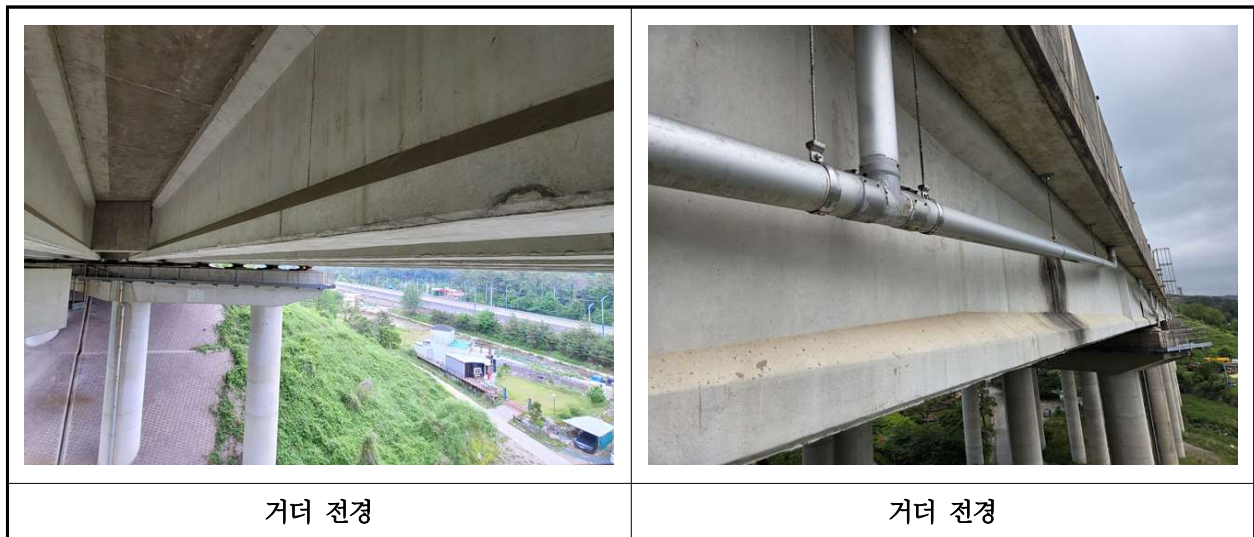
【사진 41.3.4】 거더 전경
